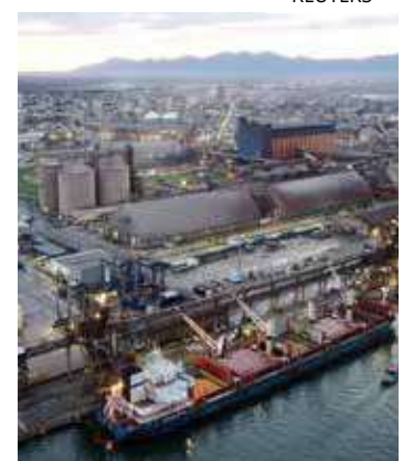
Terminal marítimo Terin em Paranaguá (PR)
