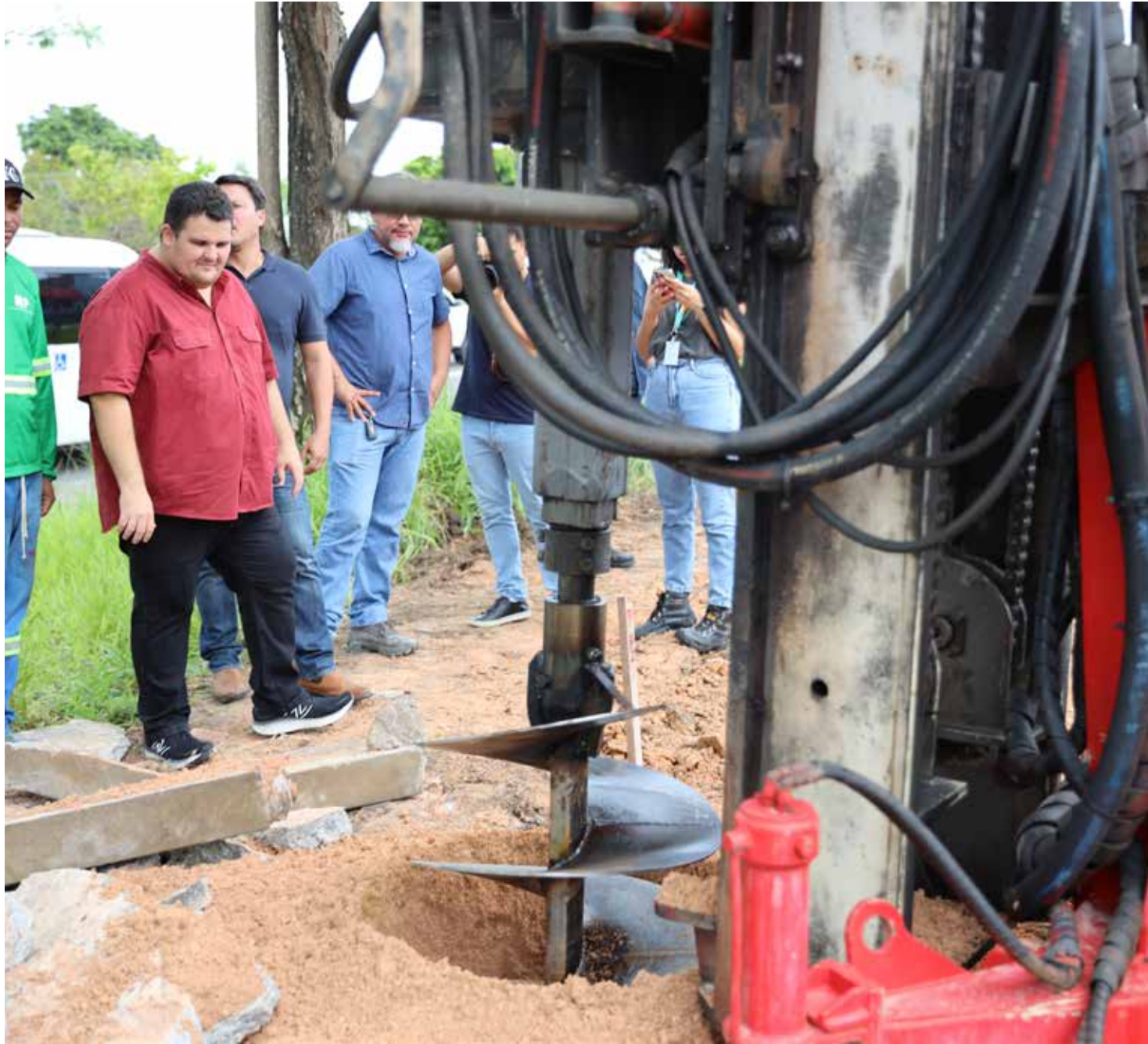
Secretario de Obras Renato Júnior acompanhou a instalação da estaca
