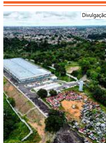
As obras já estão em 98% de sua conclusão
