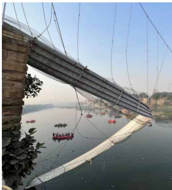
Ponte já havia caído em 2022
