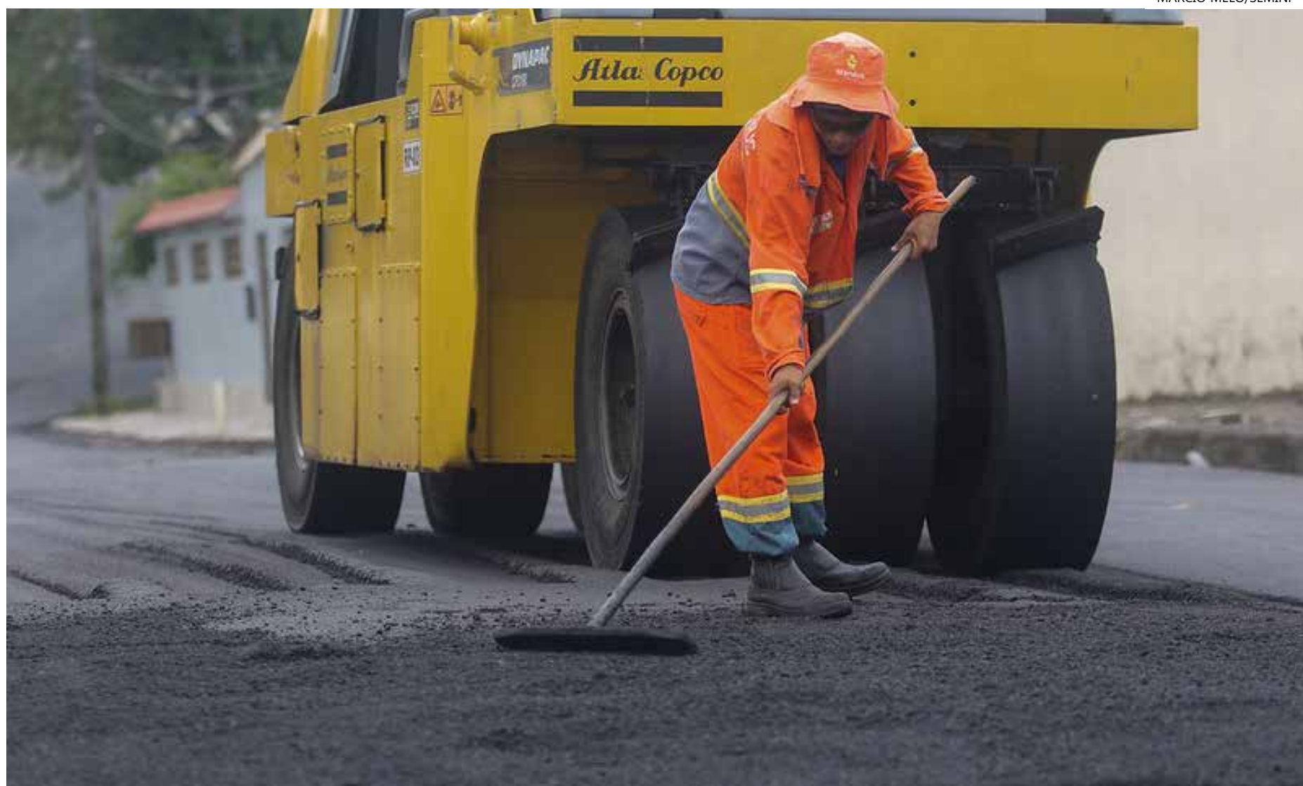
Denúncia parte de pedido por lista de ruas asfaltadas
