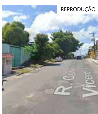
Sete linhas de ônibus serão alteradas no trecho interditado
