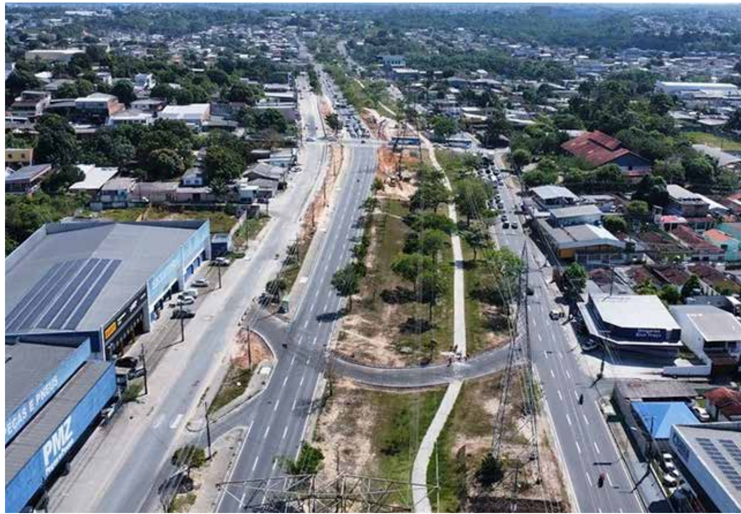
Imagem aérea do trecho da avenida das Torres que passará por interdição para obra
