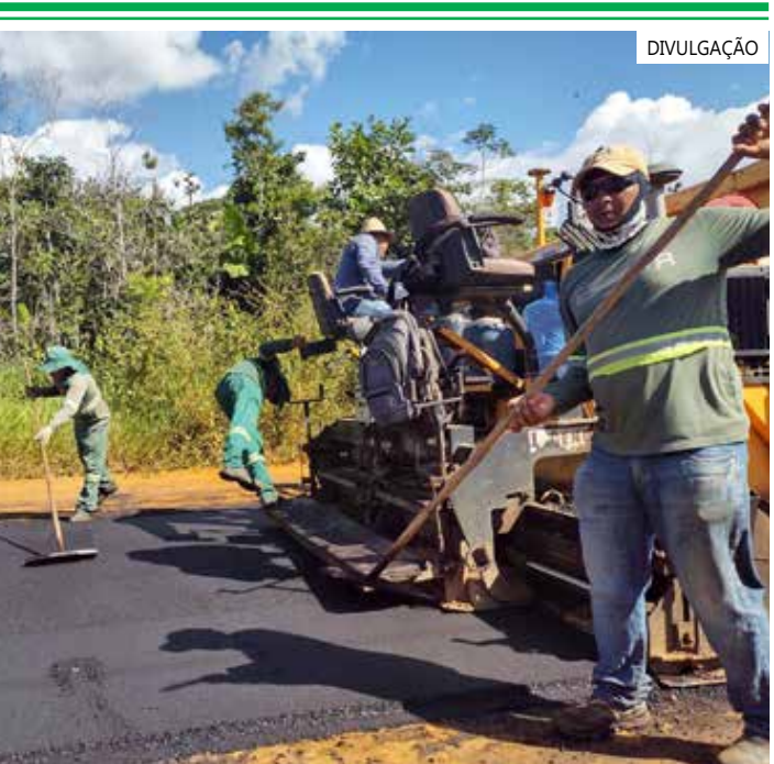
Doze quilômetros da estrada já estão concluídos.
