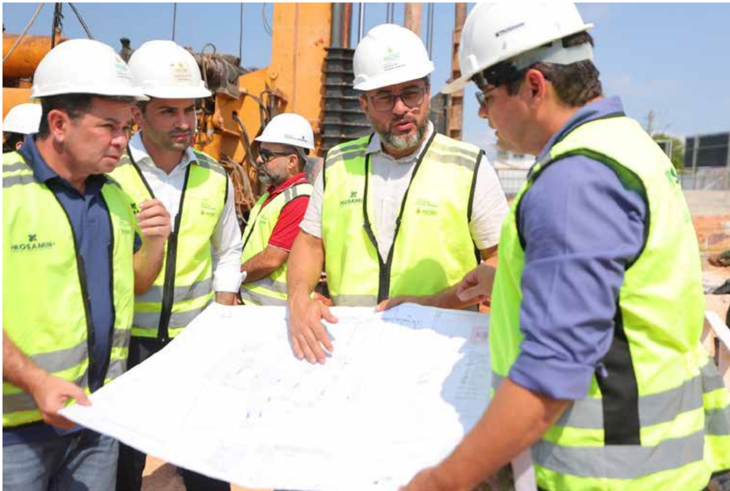
Governador vistoriou obras do conjunto habitacional na segunda-feira (14)
