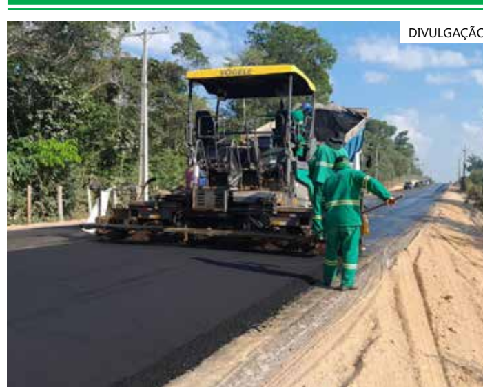
Previsão é de pavimentação asfáltica de 168 quilômetros em 2023
