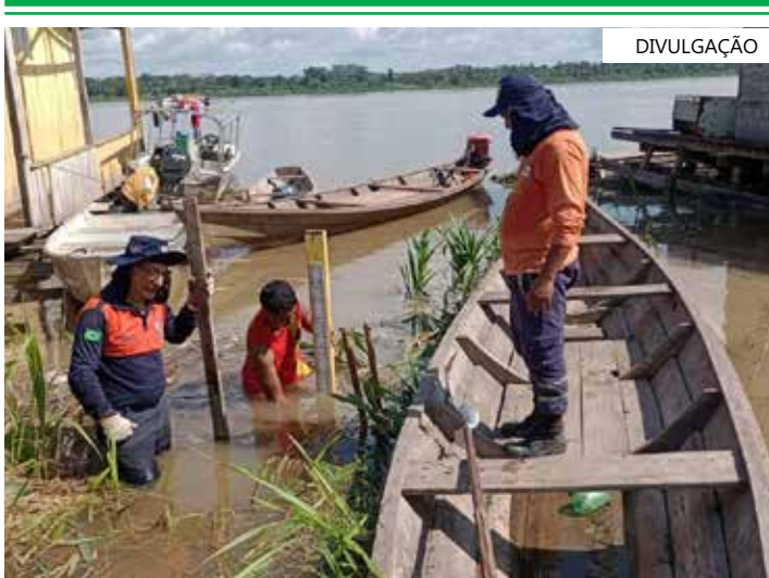
Em 2023, já foram instaladas réguas linimétricas em cinco municípios do interior do estado
