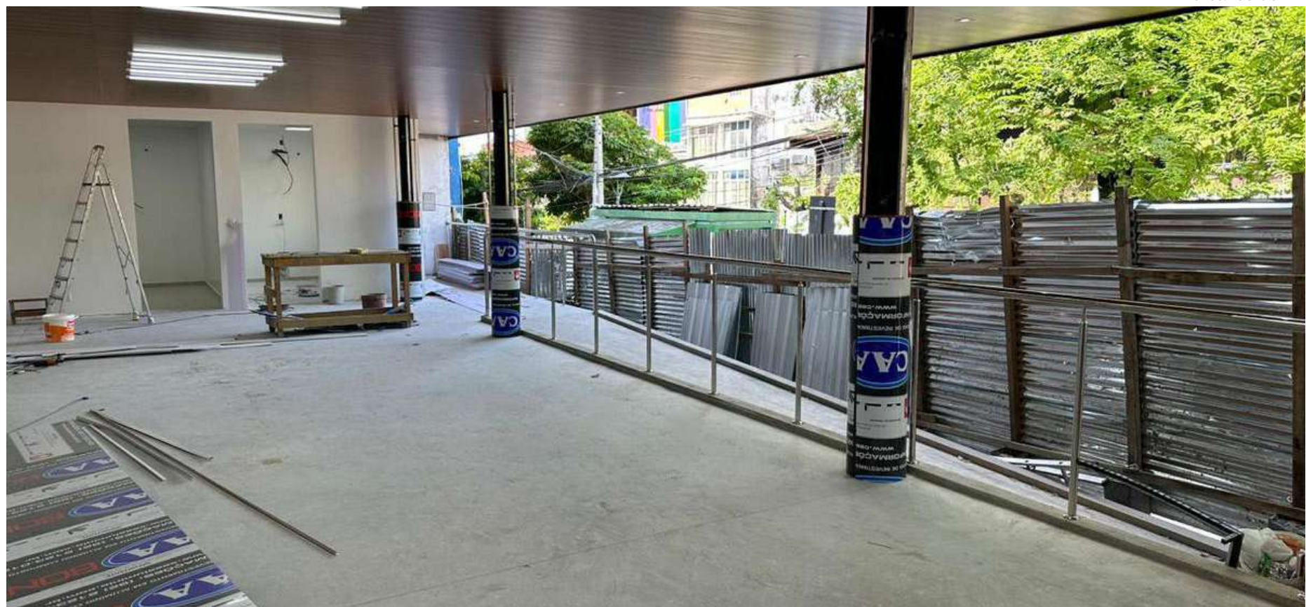
Espaço entra na fase de acabamento e será o primeiro CAT a usar energia renovável
