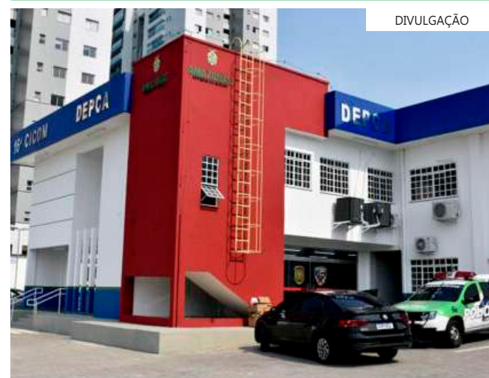
Fachada da Depca
