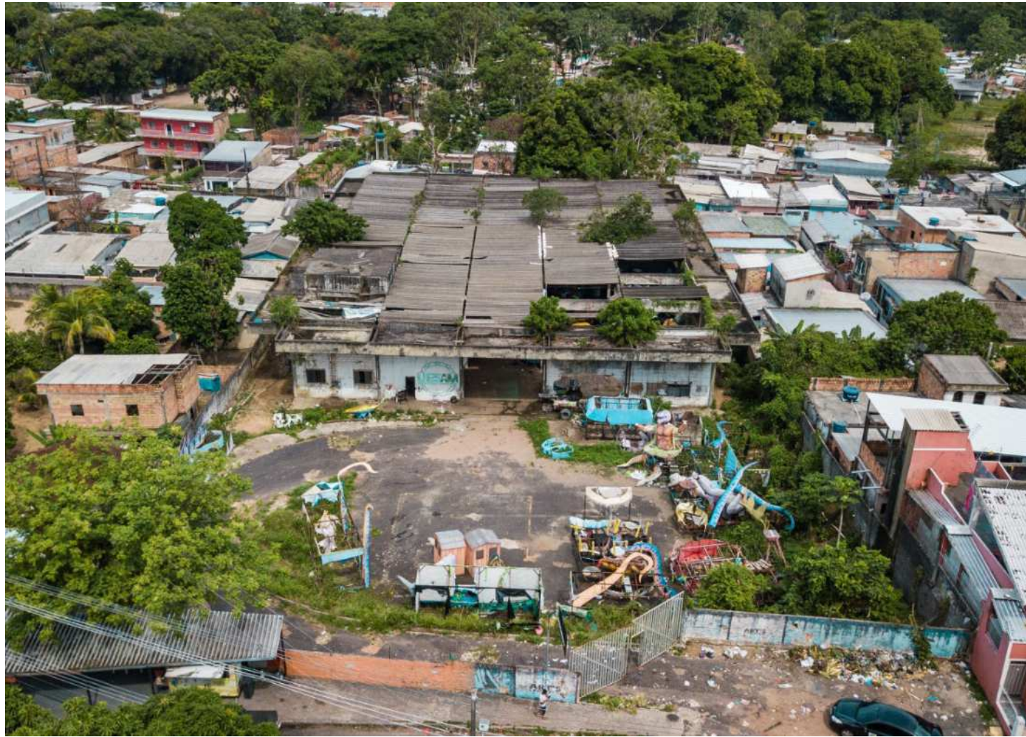
Bairro Alvorada, visa a construção de 64 apartamentos destinados a famílias pertencentes a faixa 1
