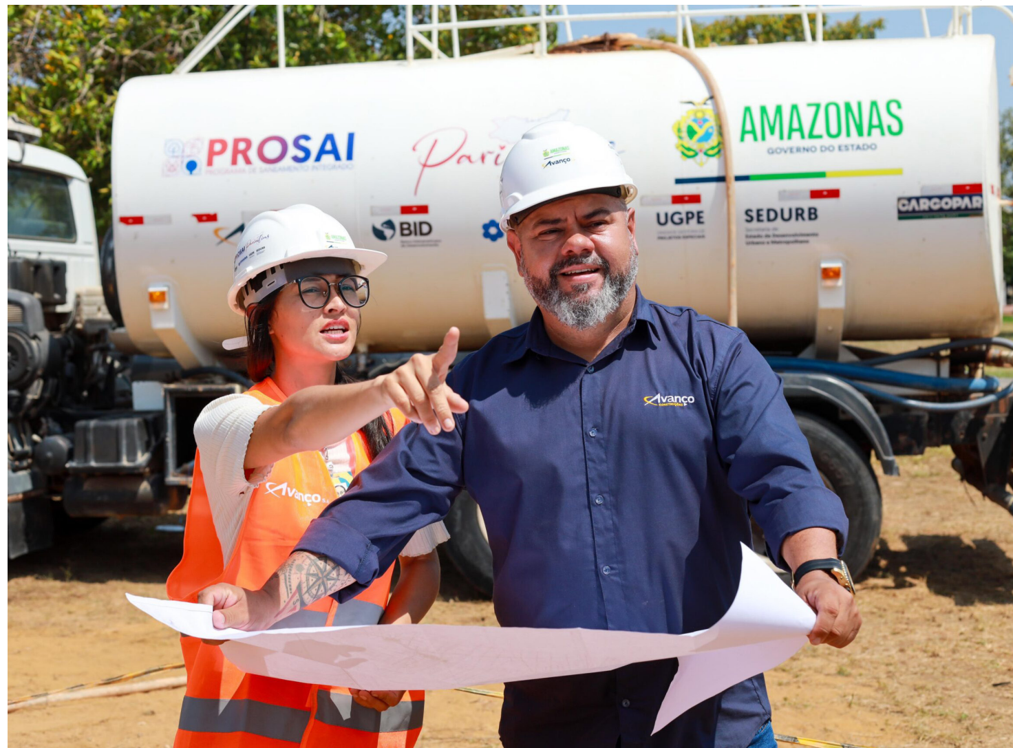
Obras do Programa de Saneamento Integrado (Prosai)
