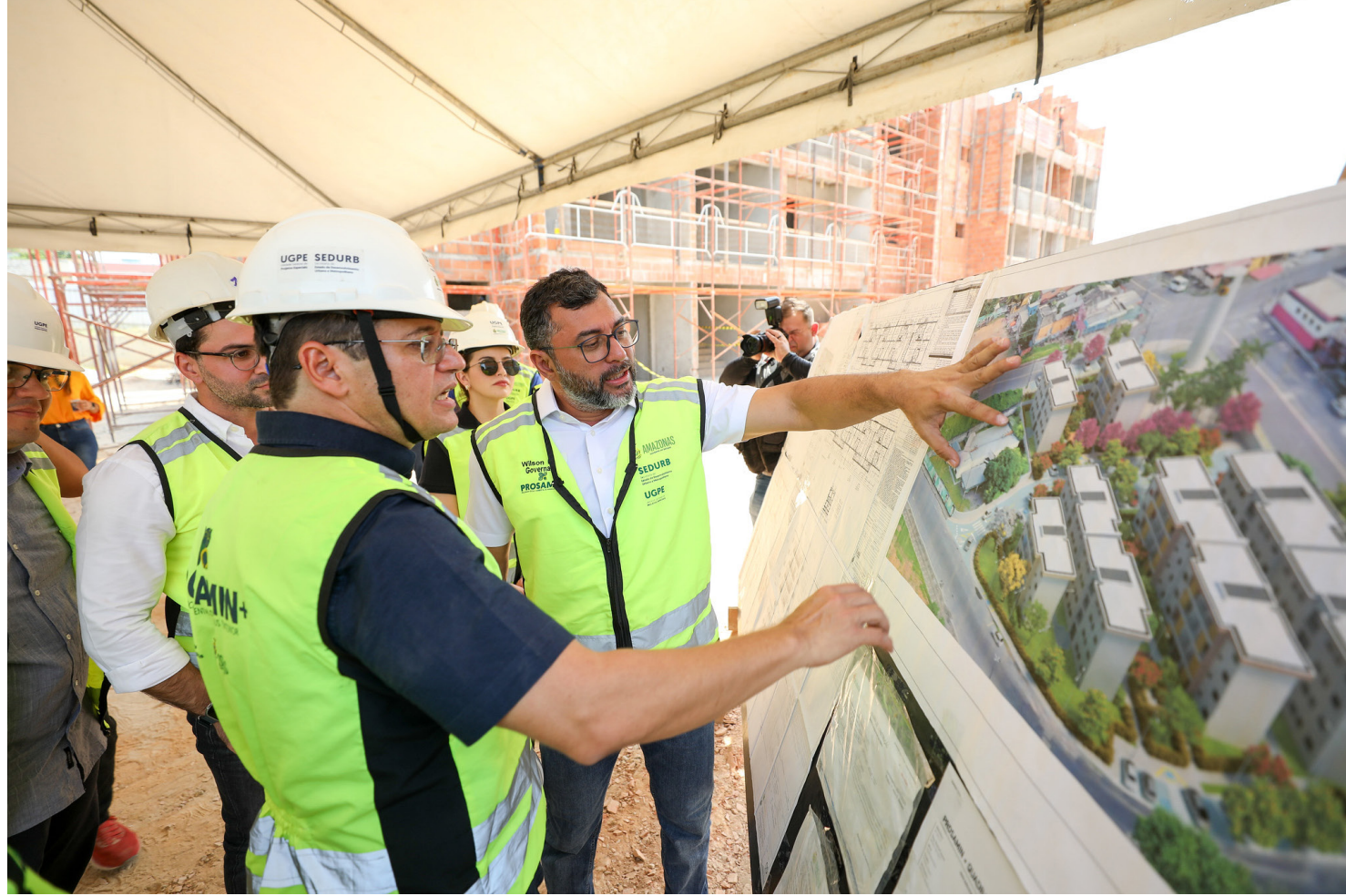
O governador Wilson Lima em vistoria no avanço das obras do conjunto habitacional Maués
