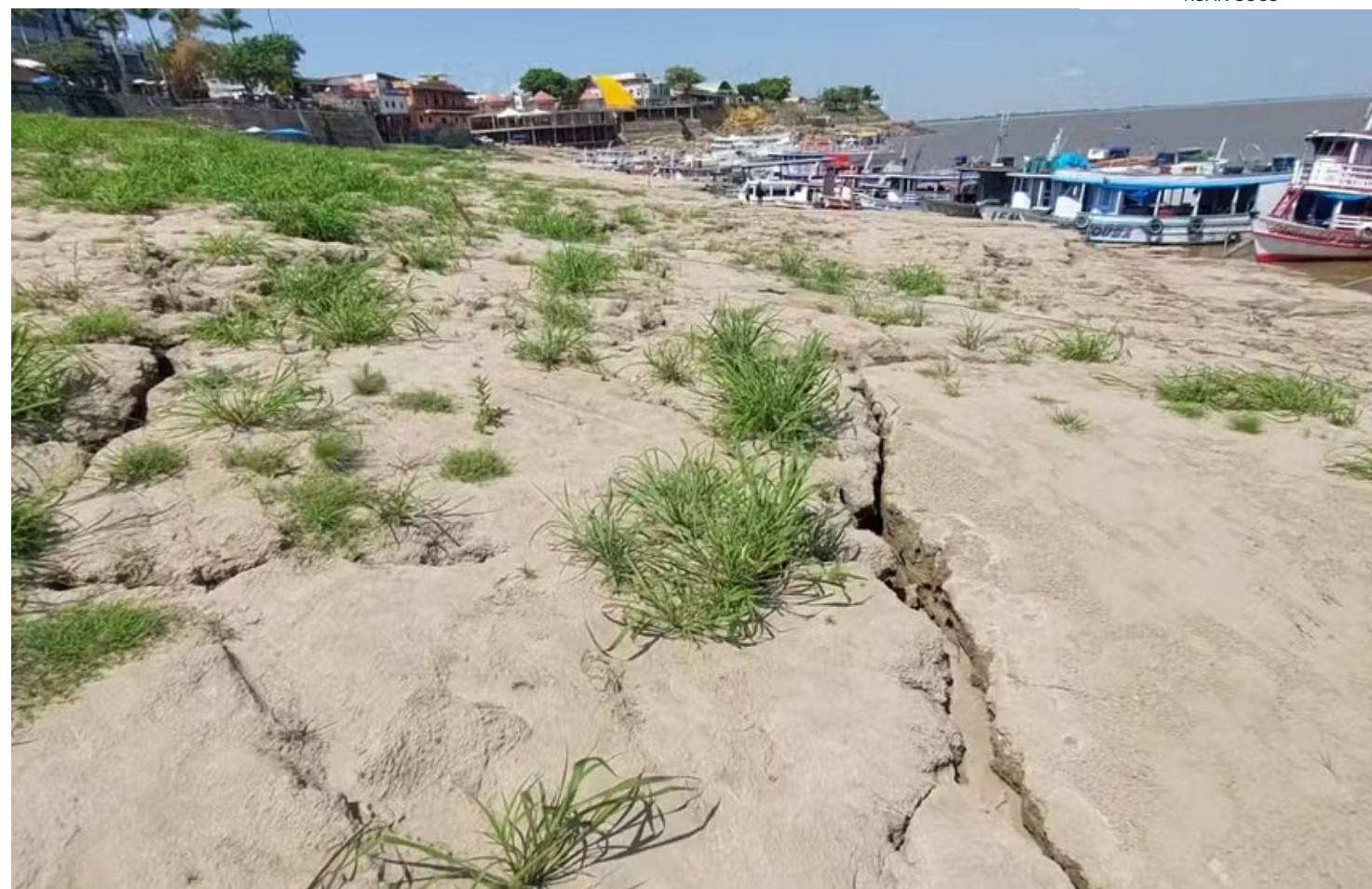
Fissuras surgem no solo do porto de Parintins, no Amazonas
