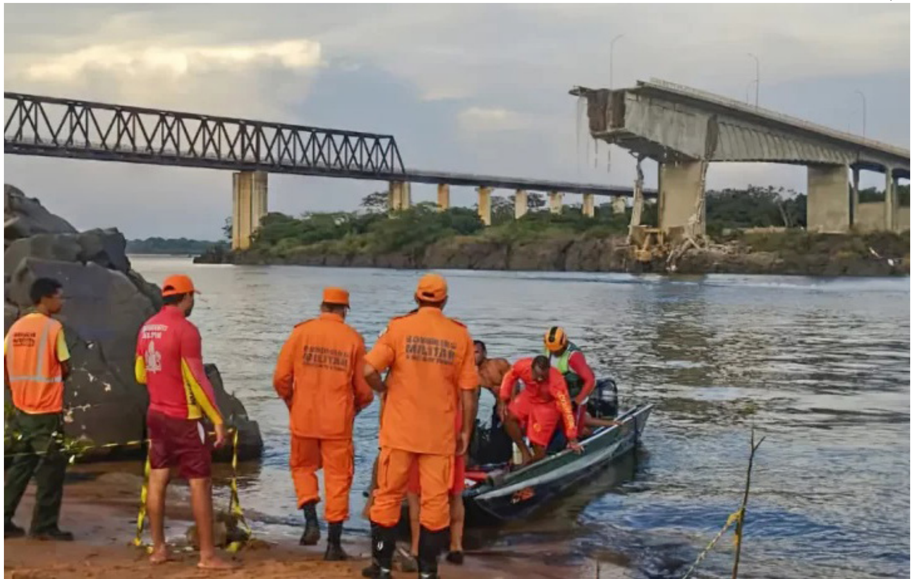
Os veículos que ficaram na ponte ainda não foram retirados devido ao risco de desmoronamento
