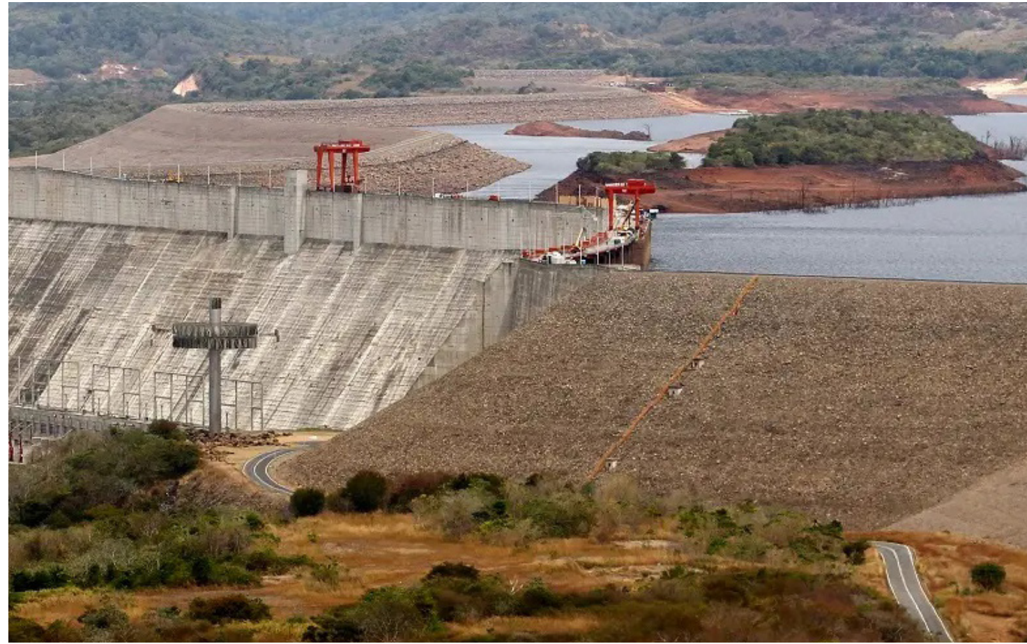
Vista da hidrelétrica de Guri, que pode exportar energia da Venezuela ao Brasil
