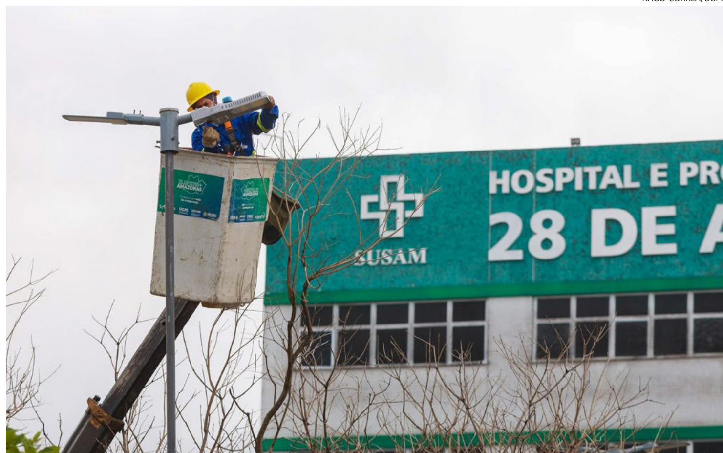
Modernização do sistema de iluminação pública das unidades da rede estadual de saúde
