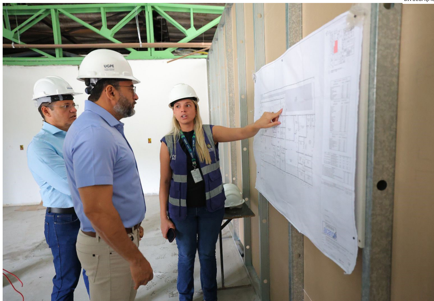
Vistoria na Fundação Hospital do Coração Francisca Mendes (FHCFM)
