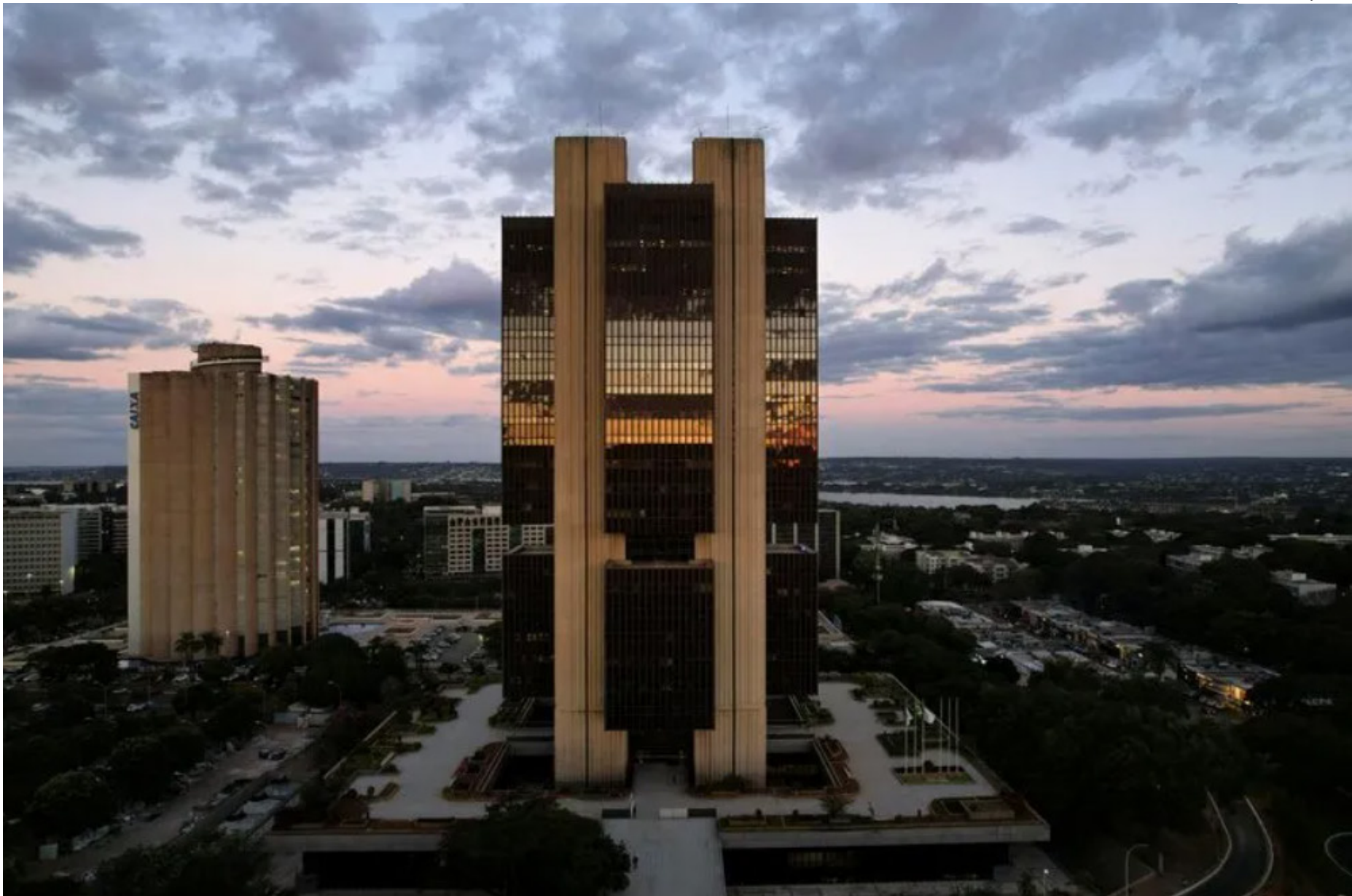
Prédio do Banco Central em Brasília
