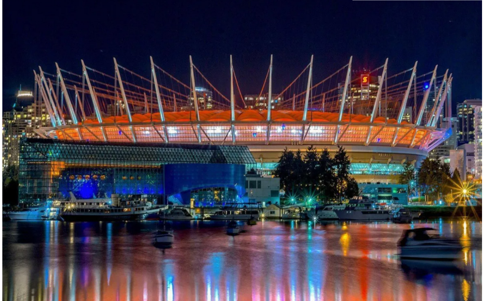
Em Vancouver, o BC Place impressiona com sua arquitetura às margens da enseada de False Creek
