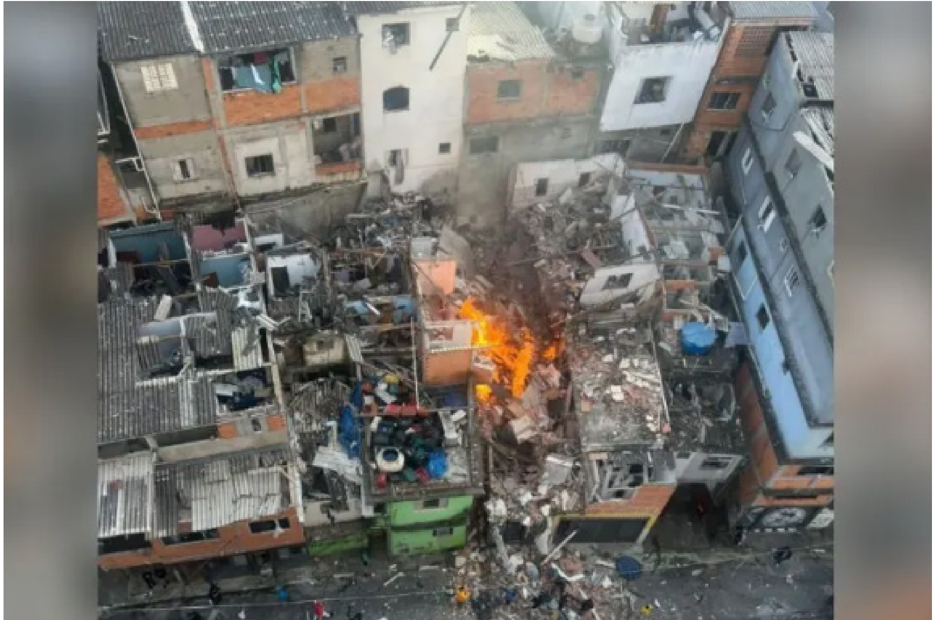
Um prédio explodiu e causou um incêndio no bairro Alvorada, na região do Jaguaré, na Zona Oeste de São Paulo
