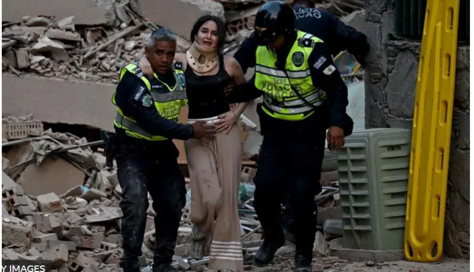
Imagens mostram danos significativos em edifícios de Caracas
