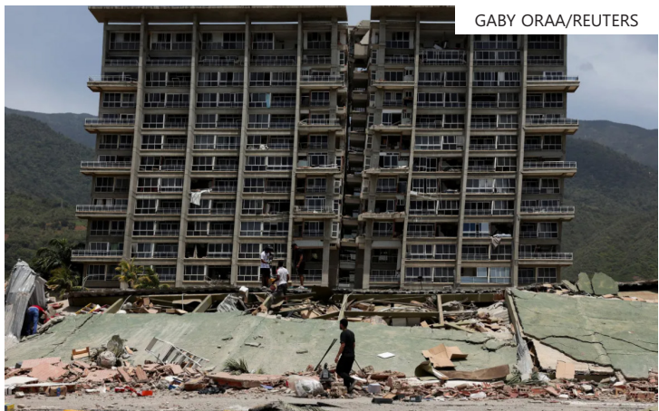
Escombros de prédio que desabou em La Guaira após terremotos na Venezuela
