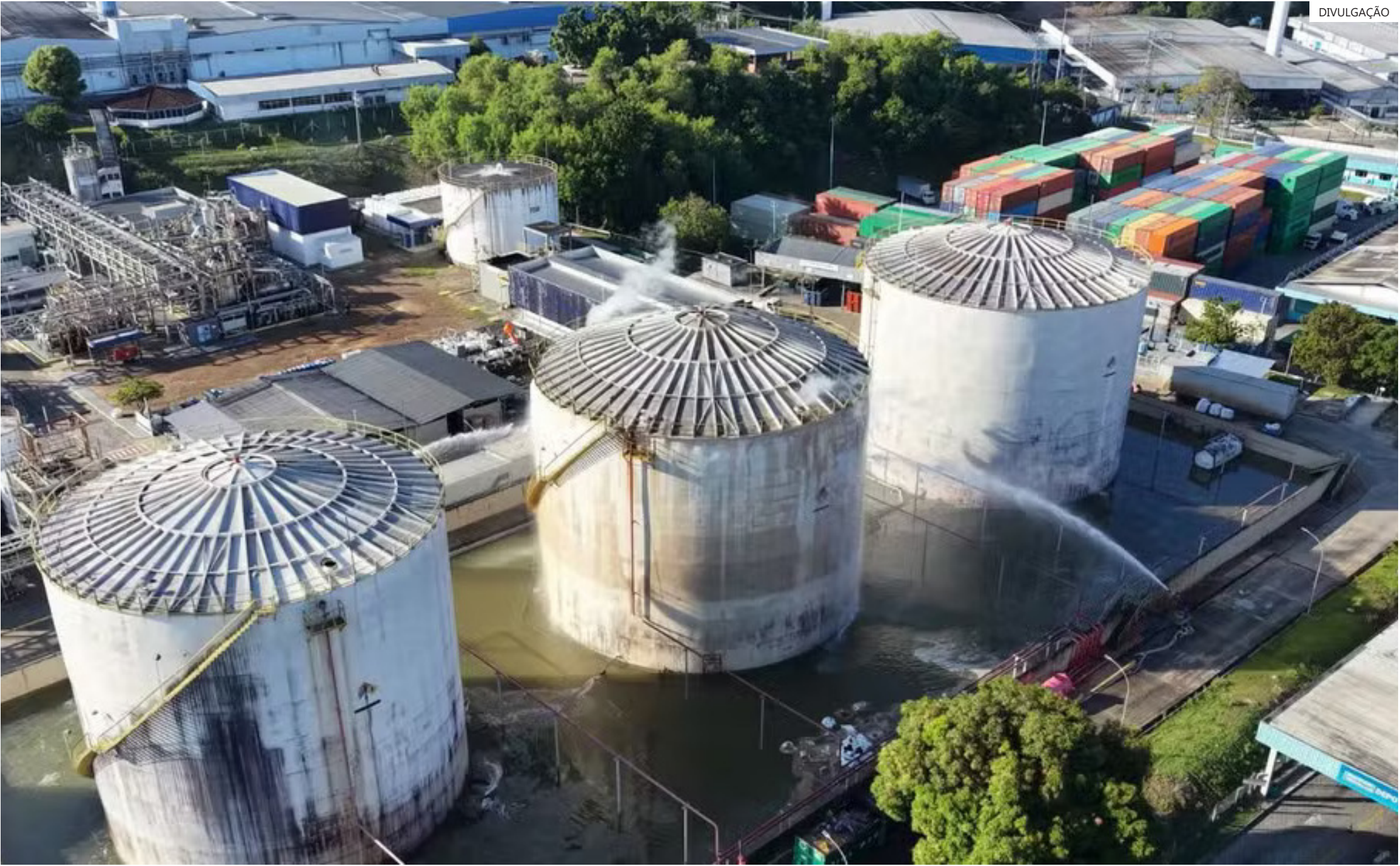
Vazamento de gás em Manaus bombeiros seguem resfriando tanques 14 horas após o incidente
