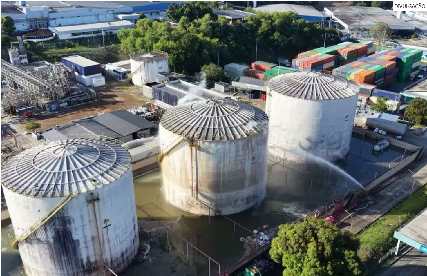
Vazamento de gás em Manaus bombeiros seguem resfriando tanques 14 horas após o incidente
