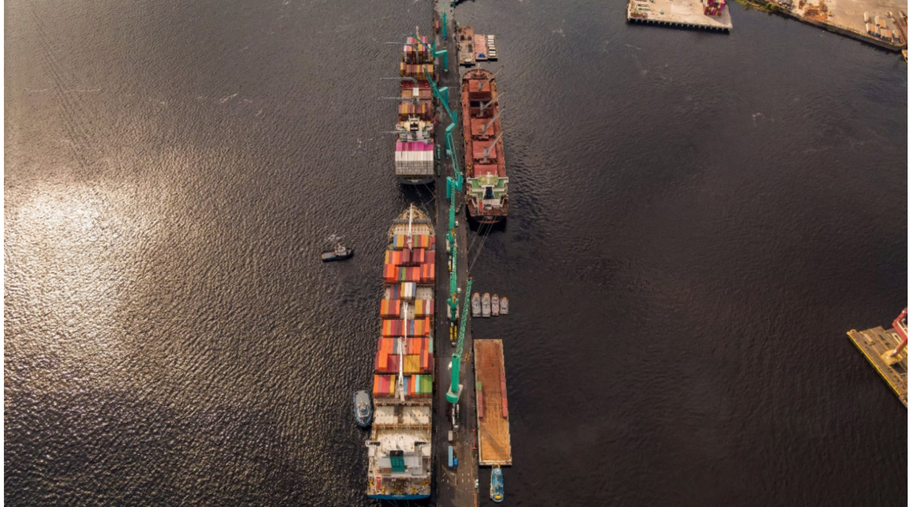
O empreendimento contará com investimento de R$ 9 milhões e aproximadamente 4,7 quilômetros de extensão
