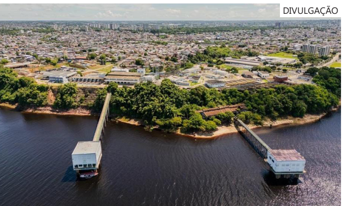
Estruturas em estações como Ponta das Lajes e Ponta do Ismael receberam bombas anfíbias e rebaixamento de equipamentos
