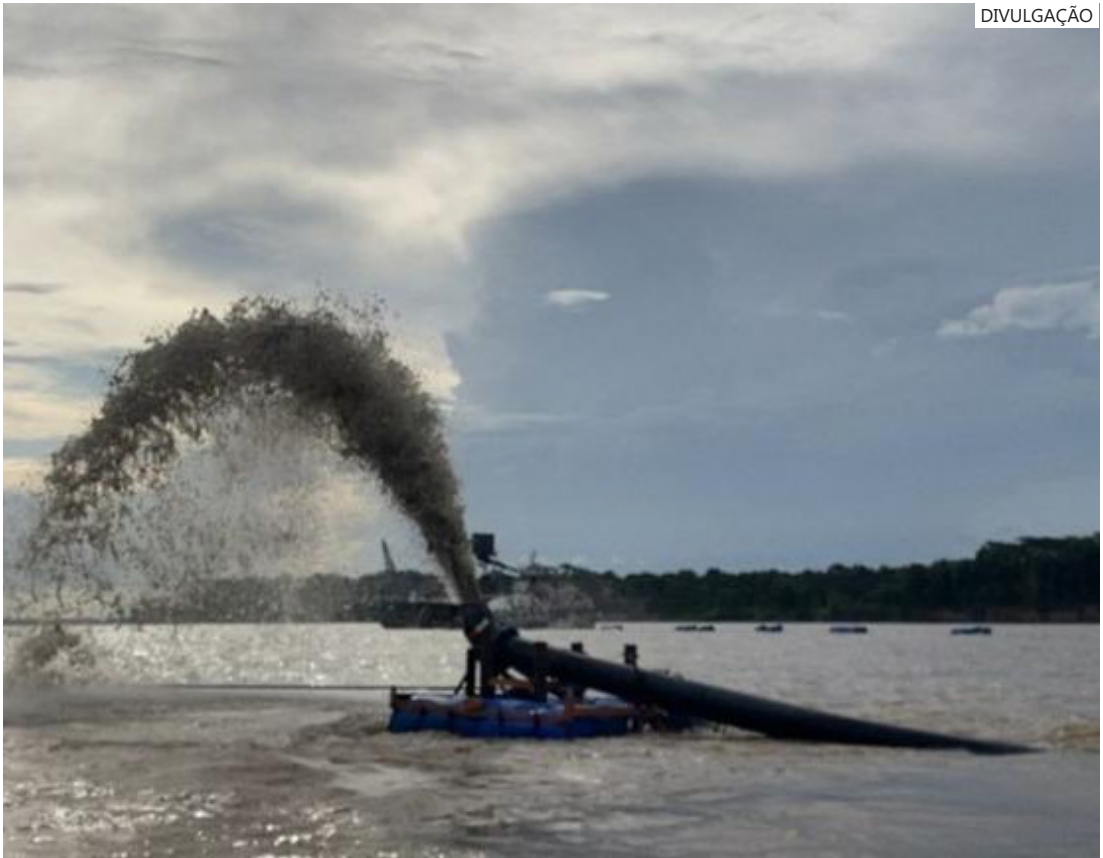
Serviços têm como objetivo manter condições adequadas de navegabilidade
