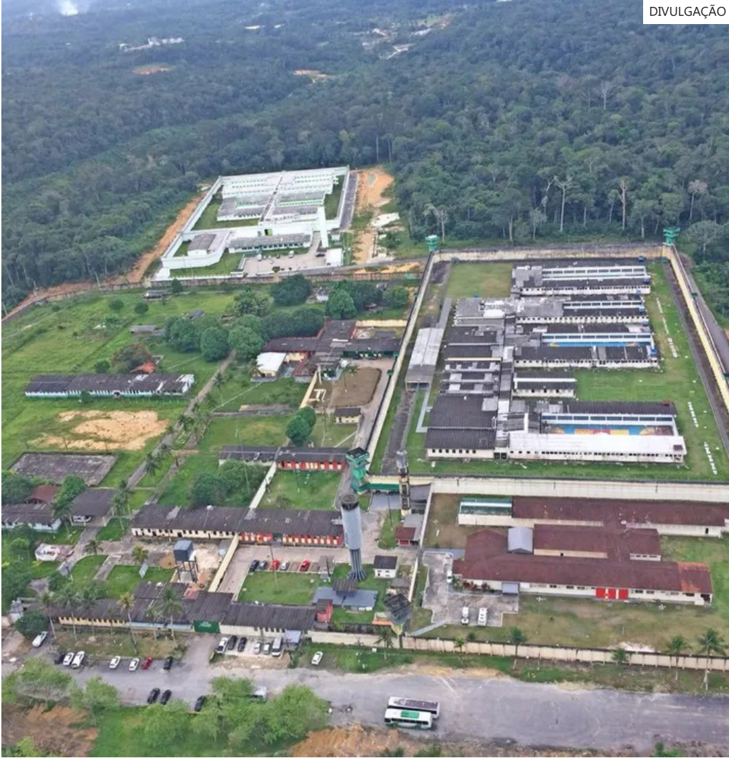
Vista aérea do Complexo Penitenciário Anísio Jobim (Compaj), em Manaus
