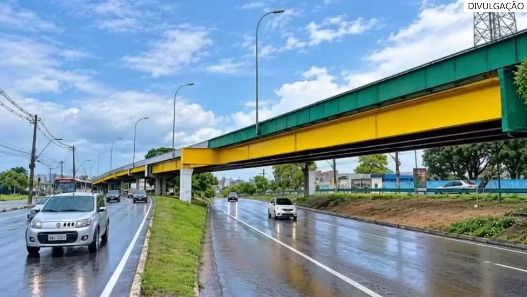
Viaduto Ayrton Senna, localizado na avenida Mário Ypiranga Monteiro, na zona Centro-Sul
